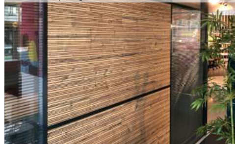
In Trennwand eingebaute Akustikplatten Panneau acoustique intégré à la cloison
