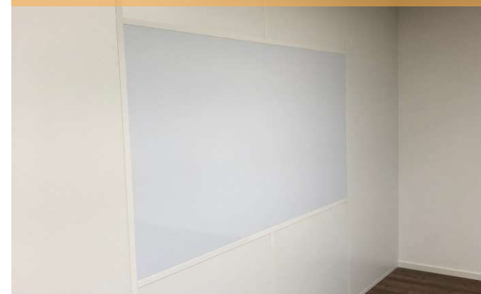
Whiteboard in Trennwand flächenbündig eingebaut Tableau blanc intégré à la cloison
