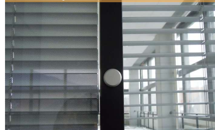
Lamellenstoren zwischen Glasscheiben in Trennwand eingebaut, Bedienung manuell Stores à lamelles intégrés à la cloison, commande manuelle
